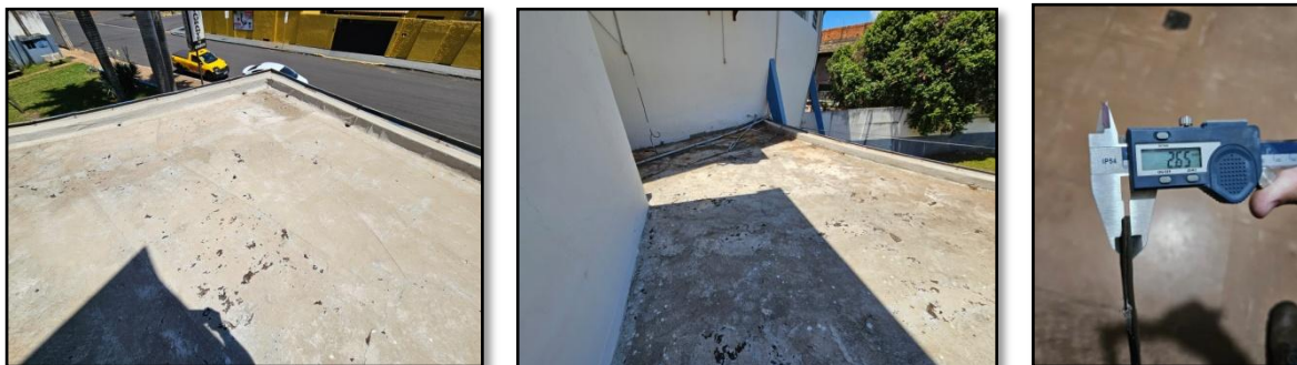
Figura 2 – Laje do local e espessura da manta.
