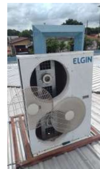
condensadora recepção também sem as hélices
