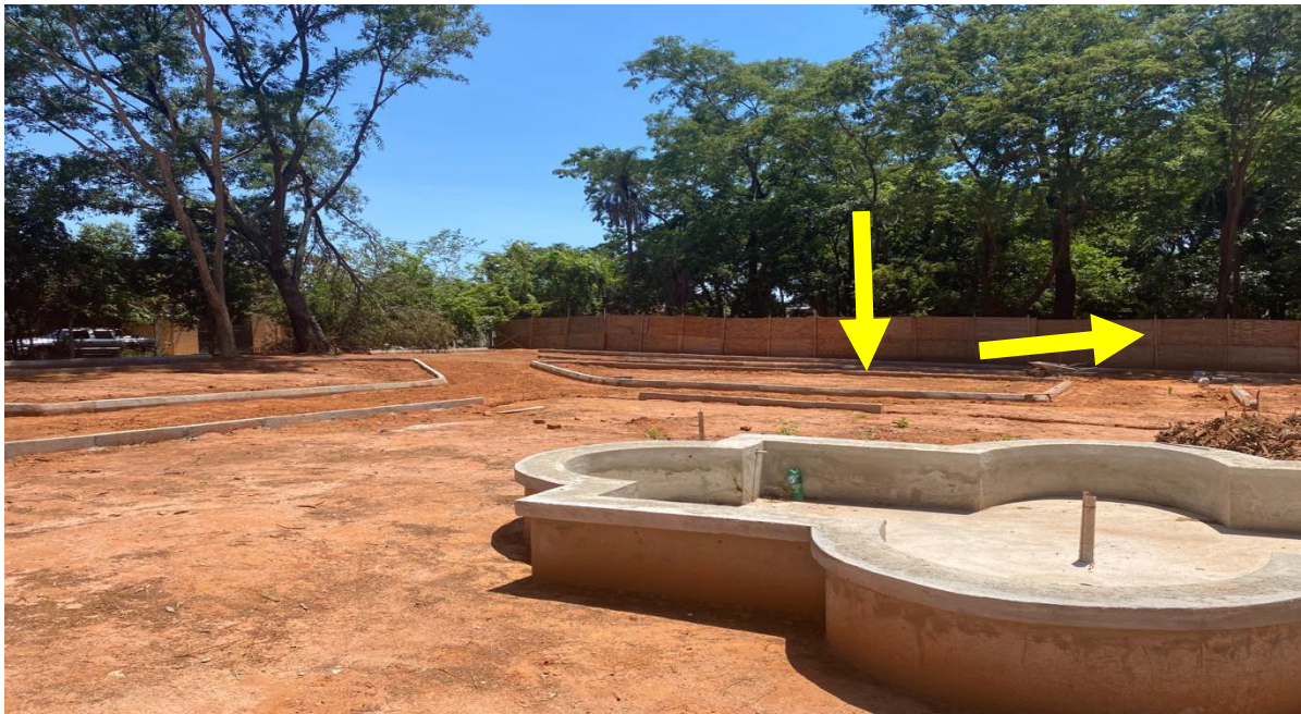
Figura 1 – Cidade da Criança com indicação dos locais de sondagens (no jardim e atrás do tapume)
